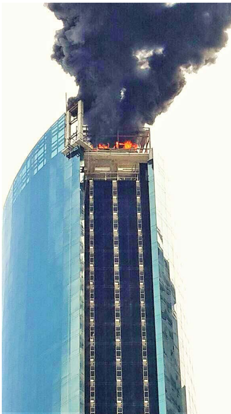
INCENDIO EN LA TORRE DE ENFRIAMIENTO EN LA AZOTEA DE ESTA TORRE DE 52 PISOS (FOTO: CORTE-SÍA DEL CUERPO DE BOMBEROS DE PANAMÁ)
