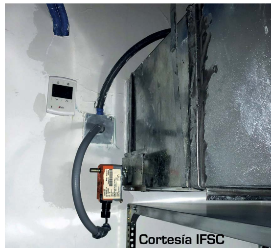
Compuerta corta humo en un ducto de aire traspasando una pared corta humo
